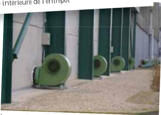
Les ventilateurs extérieurs sont directement raccordés à la gaine de 450 mm
