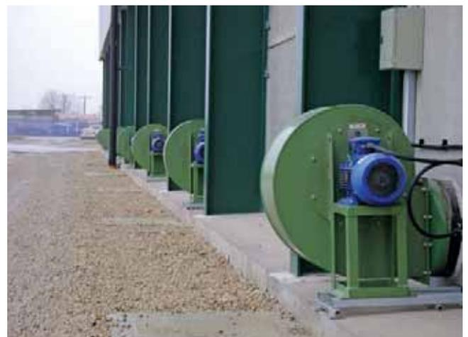
Fabriqué sur commande pour les tailles allant de 0,75 à 75 kW. Idéal pour la ventilation de gros et de faibles volumes de céréales.
